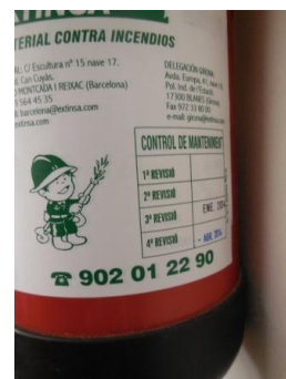
Imatge 42: Revisió extintor
