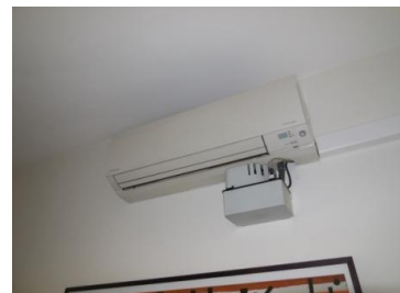
Imatge 14: Unitat interior - Split amb bomba de condensats
