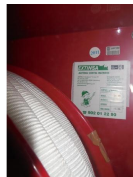
Imatge 24: Revisió instal·lació
