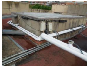
Imatge 11: Distribució conductes climatització
