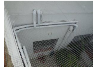
Imatge 11: Distribució conductes climatització
